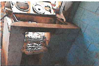
Foto 5: Sustitución de área de cocina.
