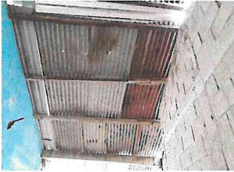
Foto1: Sustitución de lámina acanalada por lámina troquelada.
