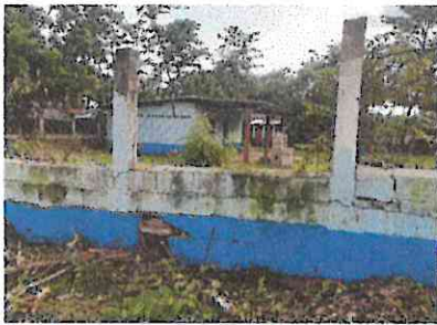
Foto 3: Sustitución de muro perimetral
